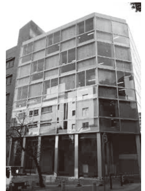
兵庫県林業会館
