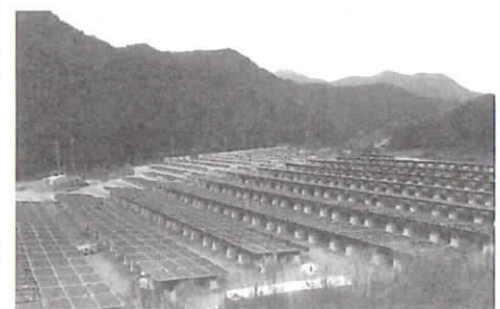
1.33メガワットの太陽光発電所を建造中
