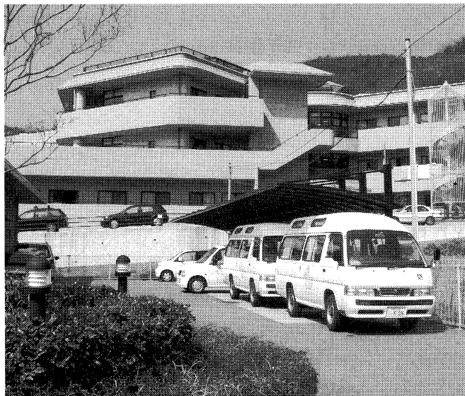
JAあいおい特別養護老人ホーム「こすもす倶楽部」の外観
