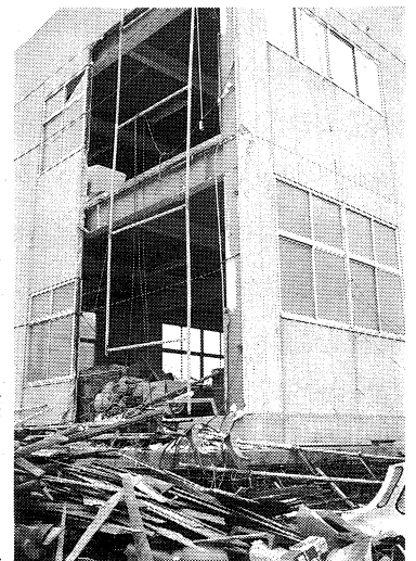
損壊した五色町漁協倉庫
