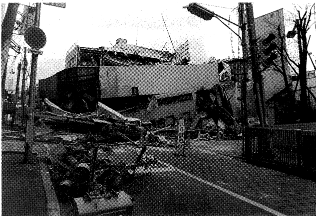
コープこうべの本部ビルが倒壊した
