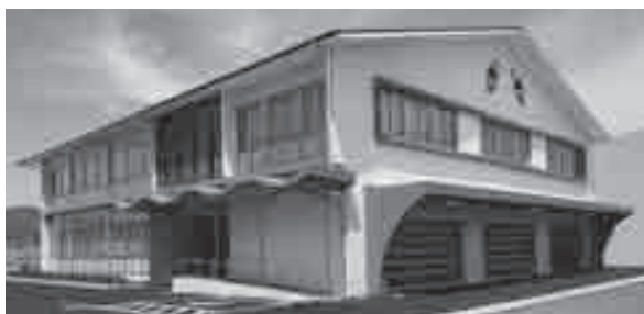
完成した新庁舎
