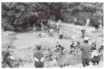
液状にした泥の掻き出し作業
