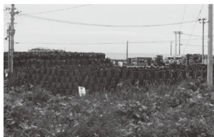
福島県富岡町の廃棄物処理施設の除染土のう袋
